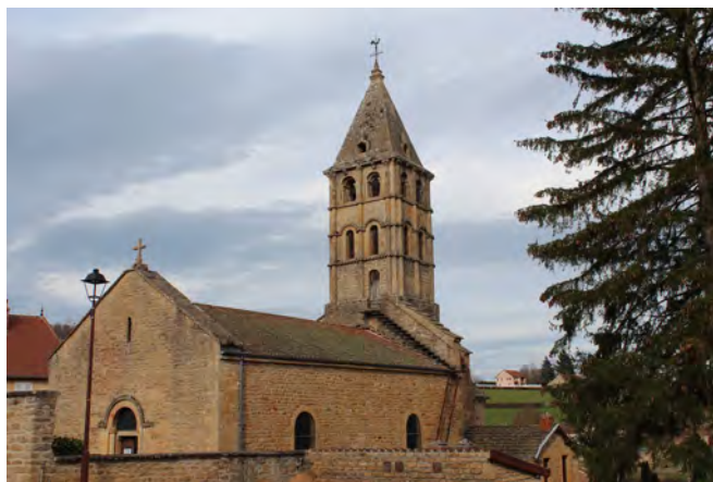
L'église de Vareilles avant la dernière restauration (© CEP)
