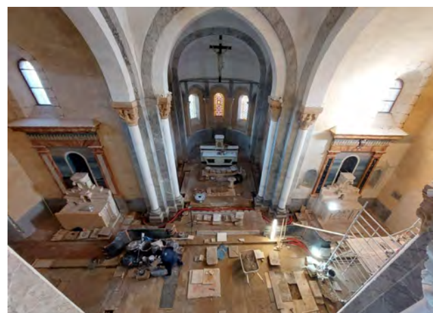
Les travaux de restauration dans l'église (© C. Gahagnon, correspondante JSL)
