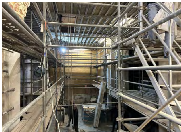
L'échafaudage à l'intérieur de l'église de Varenne-l'Arconce (© CEP)
