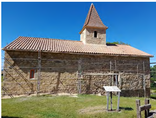
La chapelle pendant les travaux (© A.S.C.M.S.P.)
